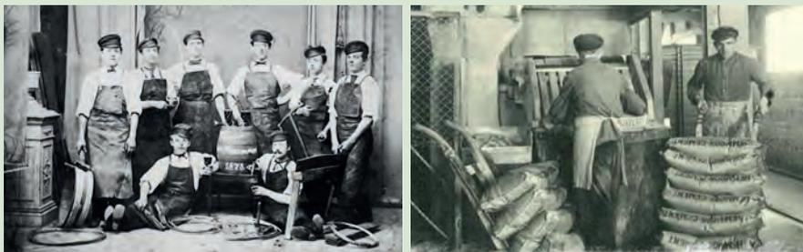
Der Zement wurde in Fässer zum Transport gefüllt. In späteren Zeiten wurde der Zement in Papiersäcke verpackt und ausgeliefert.
