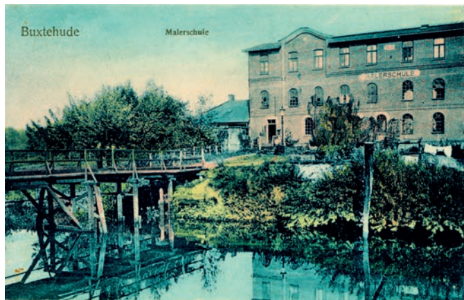
Postkartenmotive der „Alten Malerschule“ Links: colorierte Aufnahme um 1907. Das Gebäude ist schon mit den neuen Ziergiebeln an der Vorderfront ausgestattet. 1924 wurden einige Bogenfenster im ersten Stock durch größere, rechteckige ersetzt.
